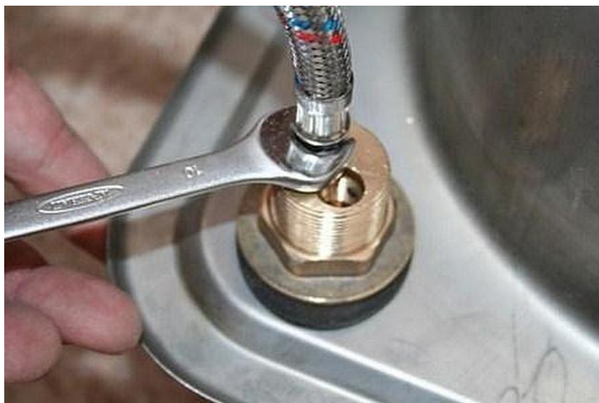
Рис. 5. Установка первой гибкой подводки.
