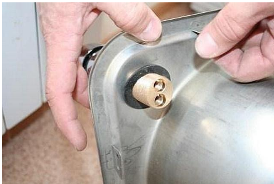
Рис. 2. Установка смесителя в отверстие в мойке.
