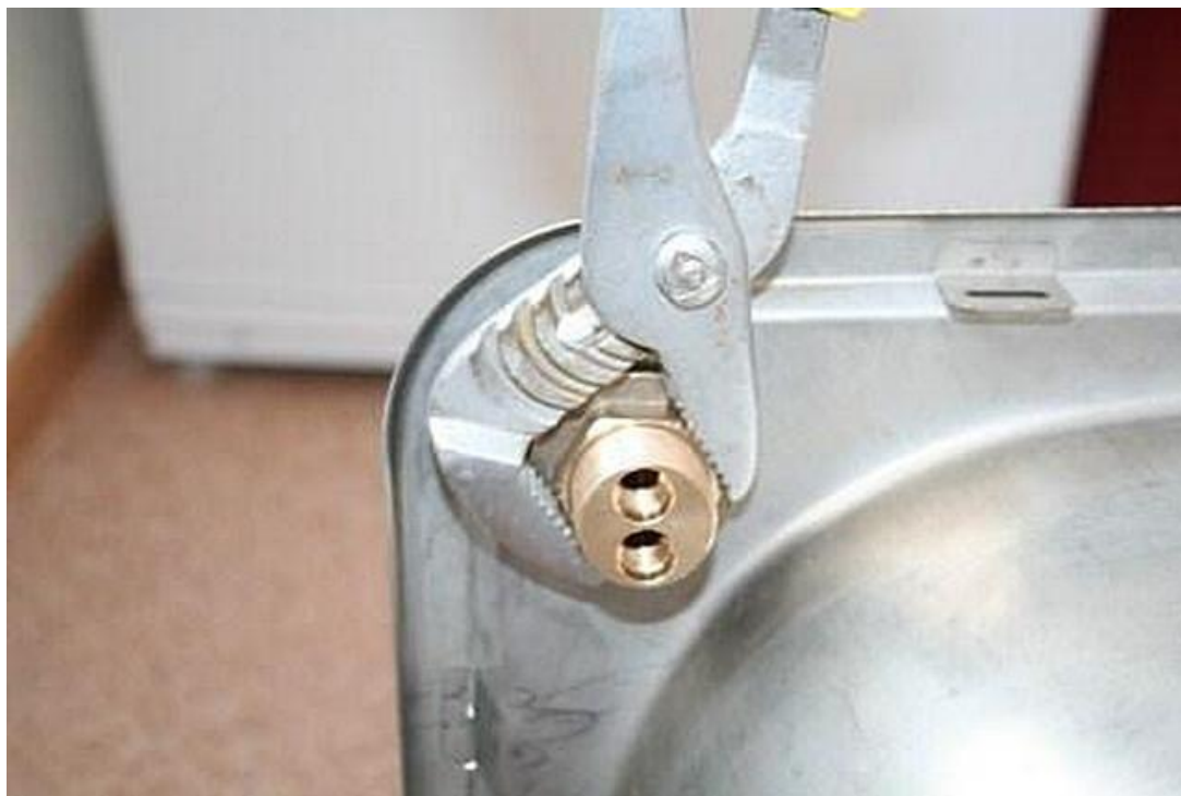
Рис. 4. Затягивание фиксирующей гайки.
