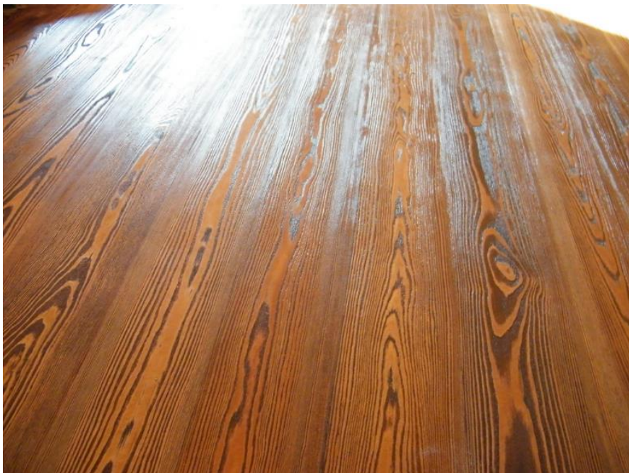
Рис. 4. Деревянный пол, покрытый маслом.
