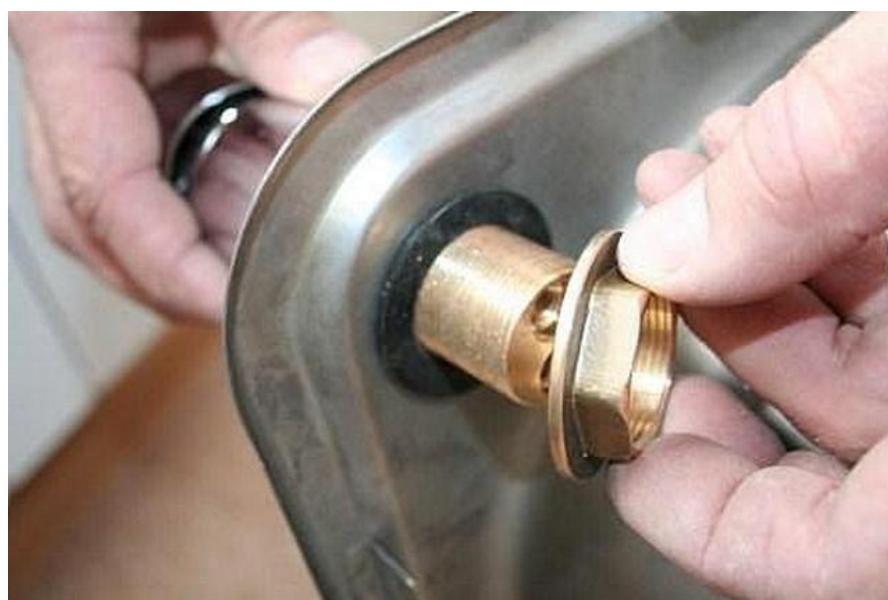
Рис. 3. Установка гайки.
